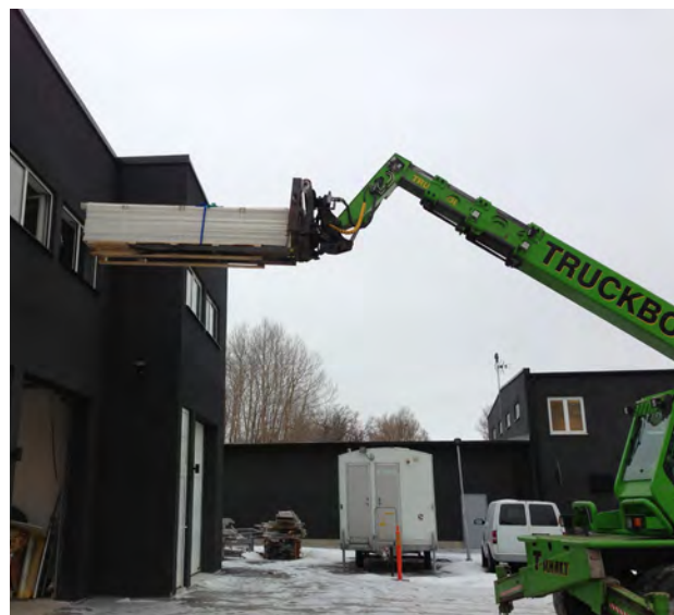
600 mm breda skivor kan lyftas in genom ett vanligt fönster vilket ger ytterligare tidsbesparingar.
