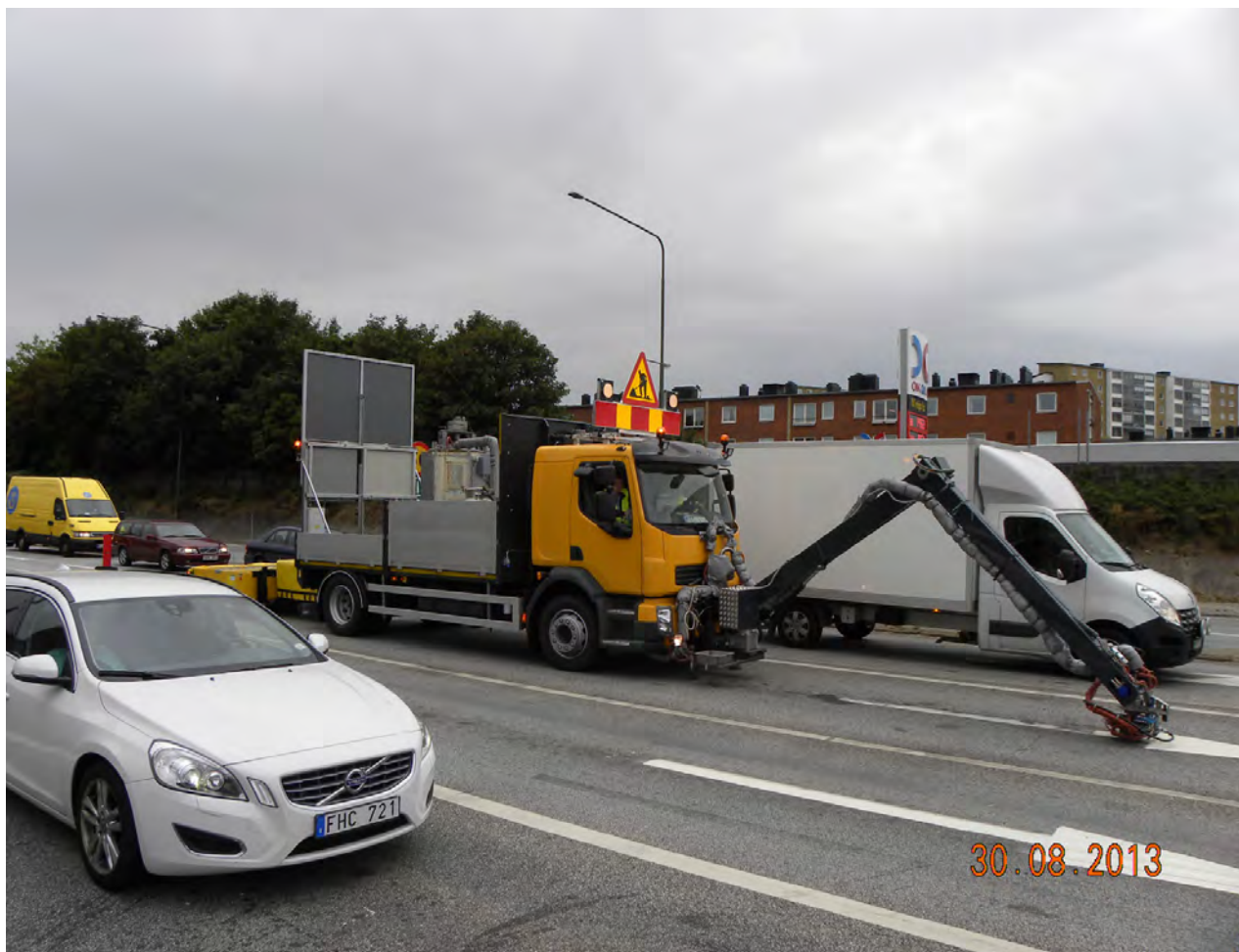
Målningsroboten klarar att lägga de flesta pilar, symboler och tvärgående vägmarkeringar.
