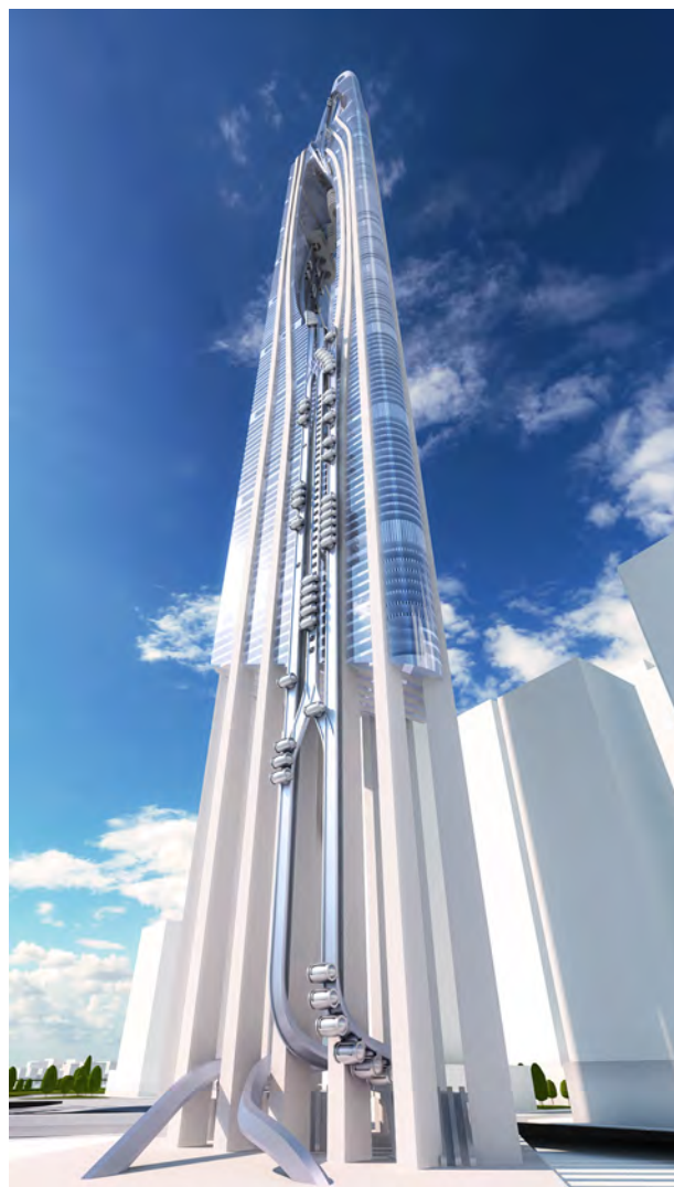
Hoplänkade hisskorgar går likt ett tåg, en Sky subway, i en slinga i byggnaden och transporterar i hög fart många människor.
